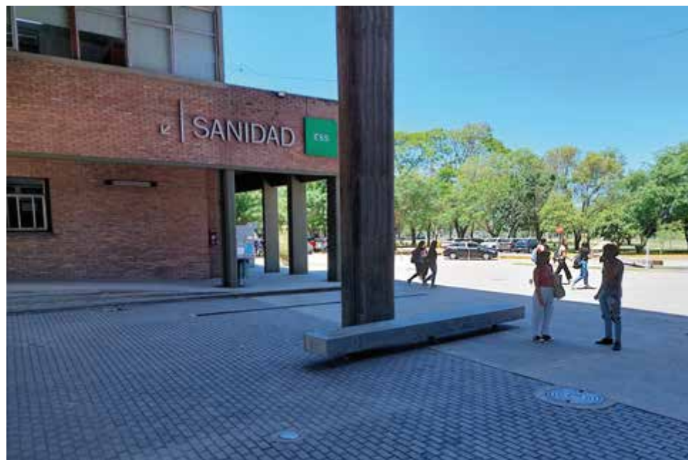
Barrera 6: Bancos de hormigón en la plaza seca, dispuestos en forma libre, sin señalización.
