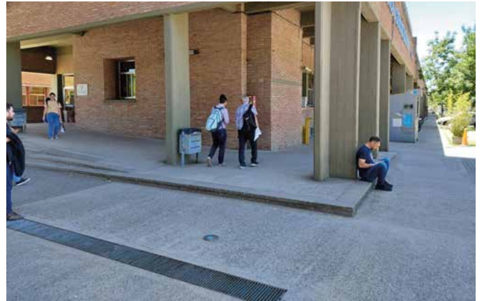
Barrera 6: Se advierte la ausencia de rampa desde la galería de FBCB hacia la plaza seca
