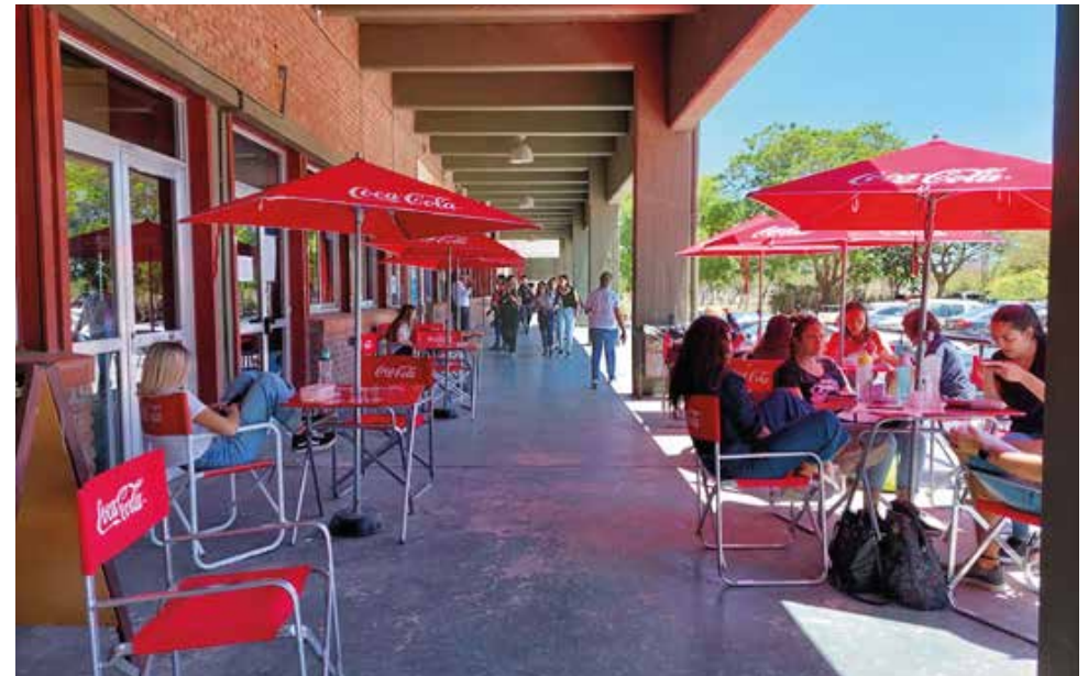
Barrera 7: La libre circulación en la Galería norte de FADU está interrumpida con sillas y mesas del bar, generando obstáculos para circular.
