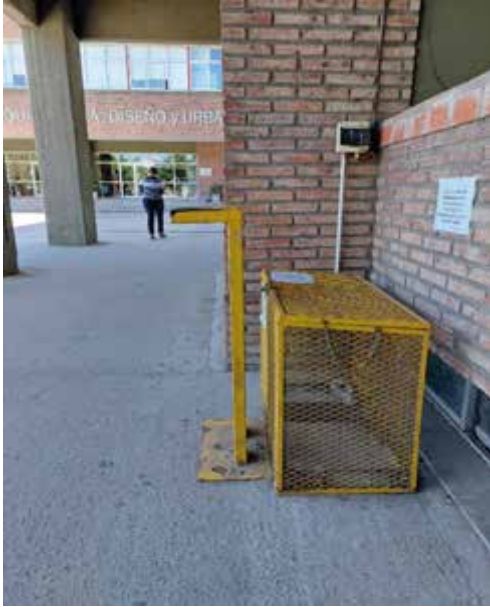
Barrera 5: Dentro de la galería, un elemento metálico de 1,20 m de altura (compresor para inflar gomas de bicicletas) sobresale y carece de señalización.
