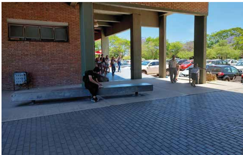
Barrera 6: Bancos de hormigón en la plaza seca, dispuestos en forma libre, sin señalización.
