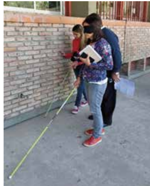
Barrera 5: Galería sin demarcación podotáctil.
