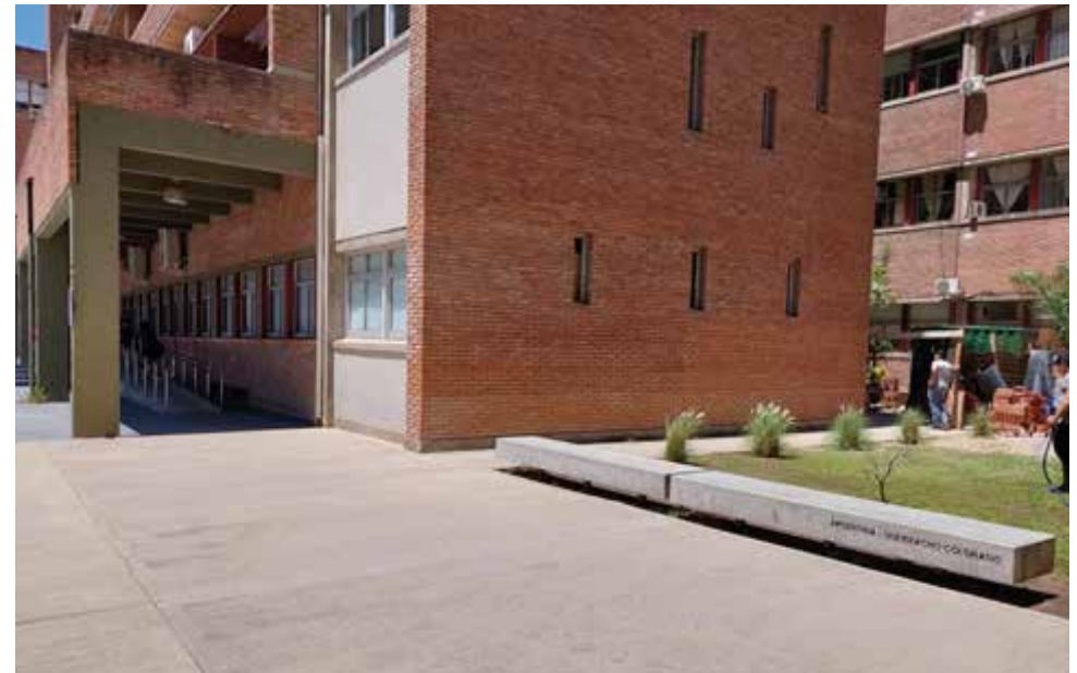
Barrera 8: El piso del camino hacia el Aulario es uniforme pero carece de elementos guía.
