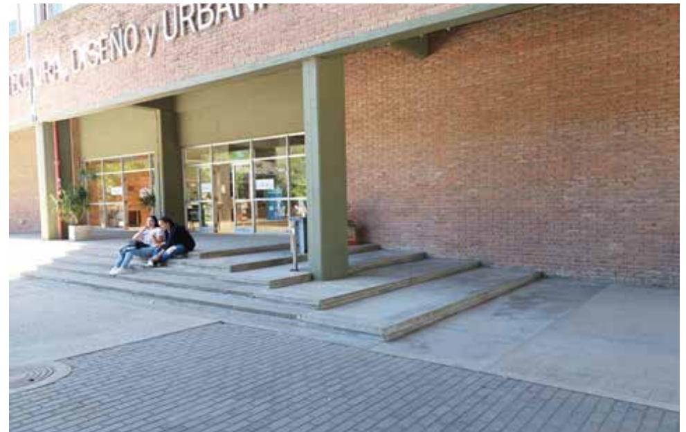
Barrera 6: el acceso a FADU/FHUC no posee rampa de acceso, ni para descender a la plaza.
