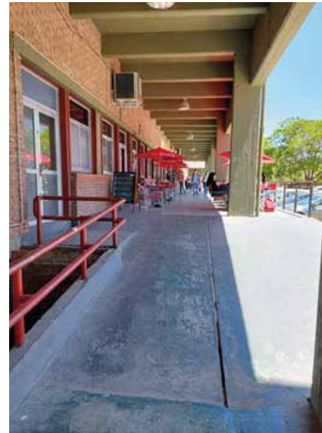
Barrera 7: Peligroso vacío en el lateral de la rampa
